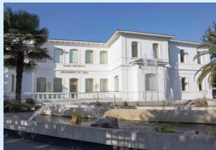
Luego de la intervención, la nueva fachada del Museo de Carabineros.
