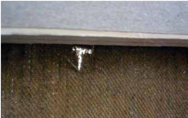
Se unieron los rasgados con PVC y espátula térmica.
